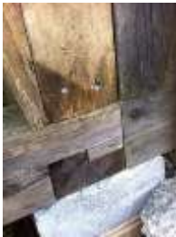
Det er i hovedsak tapping og skjøting som holder modulene sammen
